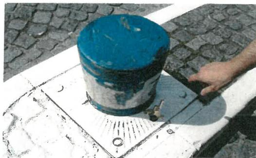
Borne escamotable et triangle de 15 mm
